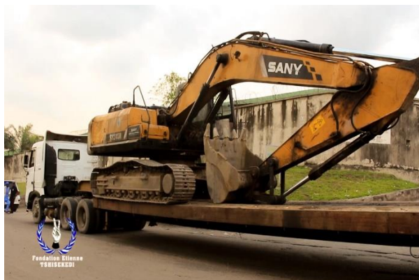
Cérémonie traditionnelle avant le lancement des travaux
